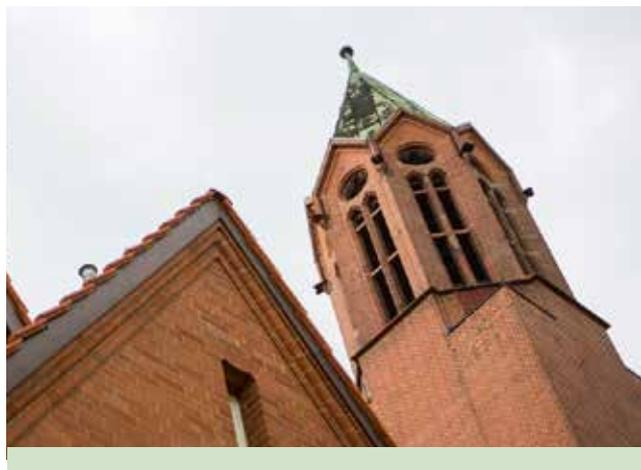
Die Backsteinfassaden wurden mit Quarzsand abgestrahlt: „Die Klinker leuchten wie neu, obwohl das Originalmaterial von 1914 ist“
